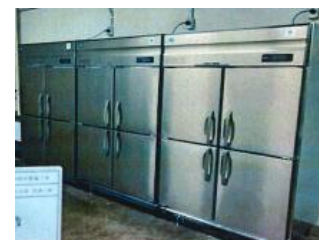
食材保管用の冷蔵庫
